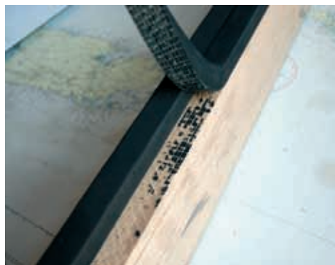
Ljepilo čvrsto drži pa ako traku želite odlijepiti i ponovno zalijepiti, nećete dobiti dobre rezultate jer je dio ljepila i gume ostao na prethodnom spoju
